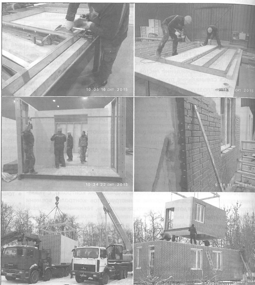
Рис. 5. Примеры фотофиксации основных процессов сборки конструктивных элементов и монтажа модульного дома
