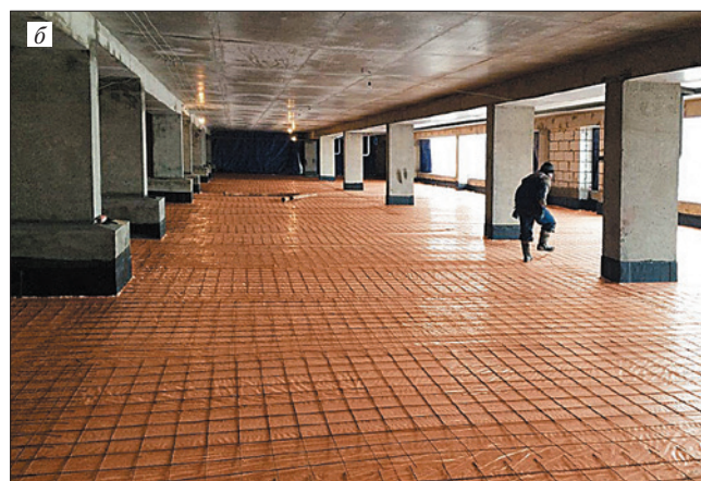
Рис. 3. Использование теплоизоляции ПЕНОПЛЭКС® при возведении подземных паркингов: а — внешнее утепление потолка; б — утепление фундаментной плиты
