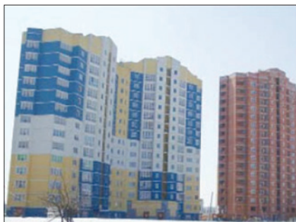
Рис. 7. Строительство многоэтажного здания
