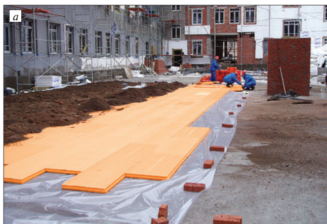
Рис. 3. Использование теплоизоляции ПЕНОПЛЭКС® при возведении подземных паркингов: а — внешнее утепление потолка; б — утепление фундаментной плиты
