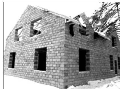
Рис. 4. Блочное строительство коттеджа
